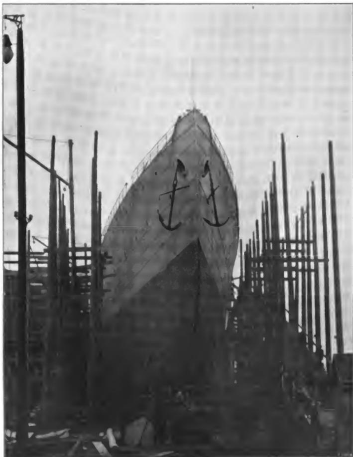
Fig. 3. Das Schul- und Transportschiff „Okean“ im Bau.
